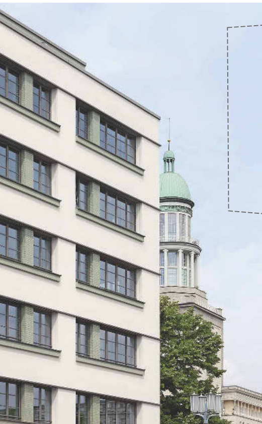
Die Fassade wurde energetisch ertüchtigt und formal reprogrammiert.
